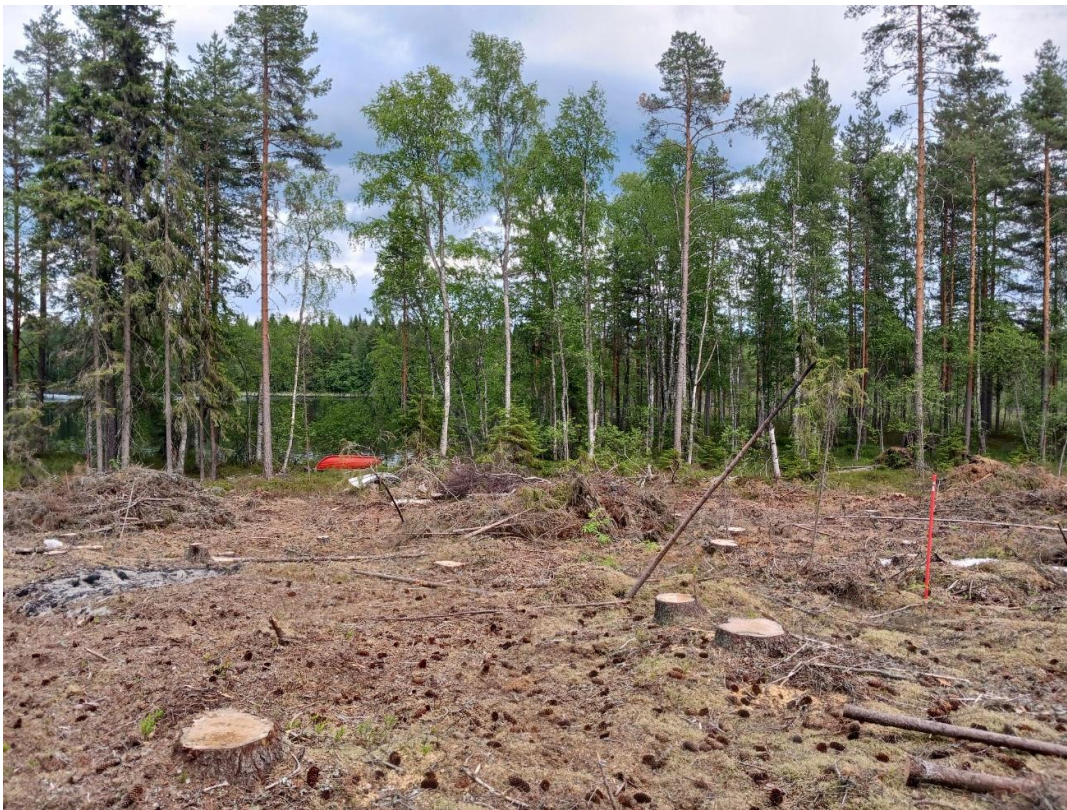
Kuva 4. Kuvattu rakennusalueen keskivaiheilta koilliseen. Suojapuustoa jätetty rannalle.
