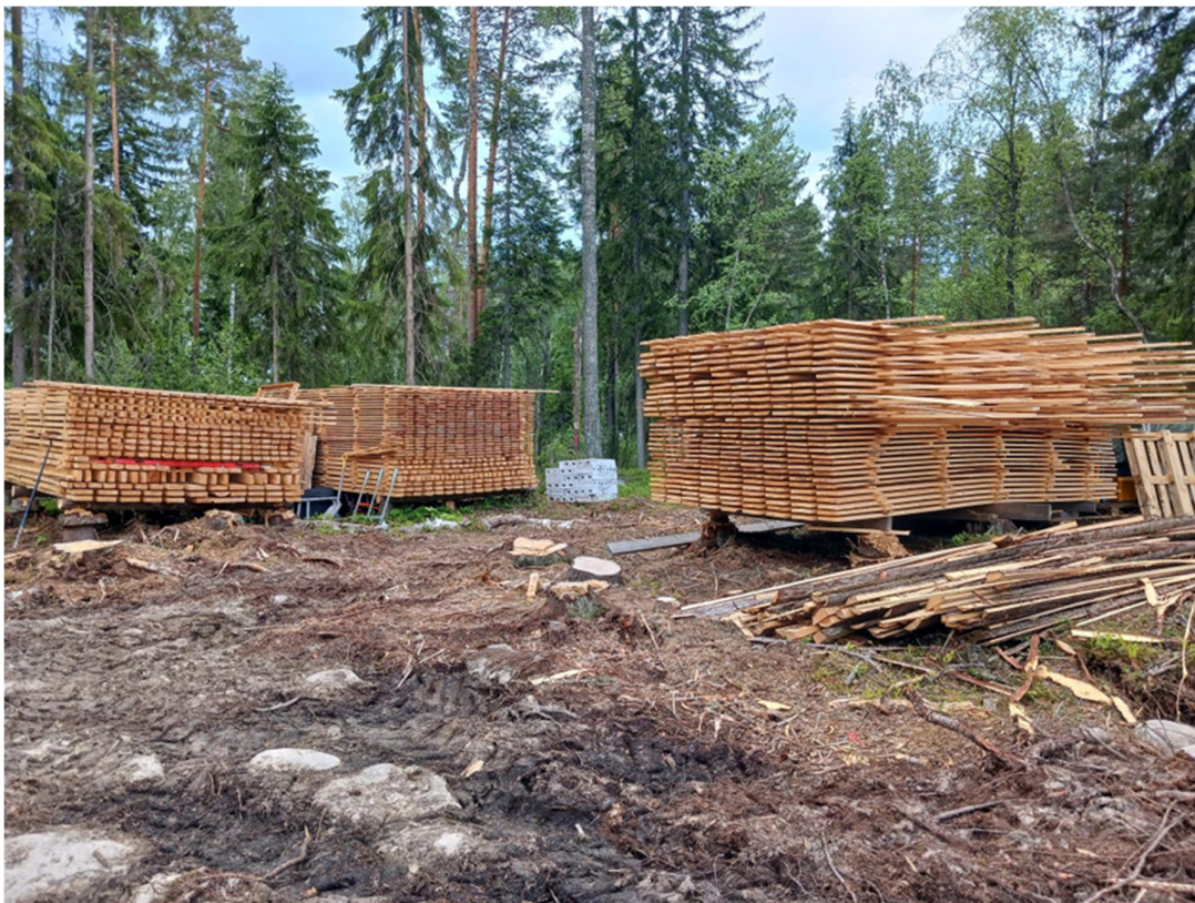
Kuva 6. Rakennusalueen puista kenttäsiirkelillä sahattu puutavara kuivumassa "taapeleissa".
